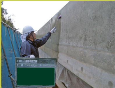
S クリートアップの塗布
